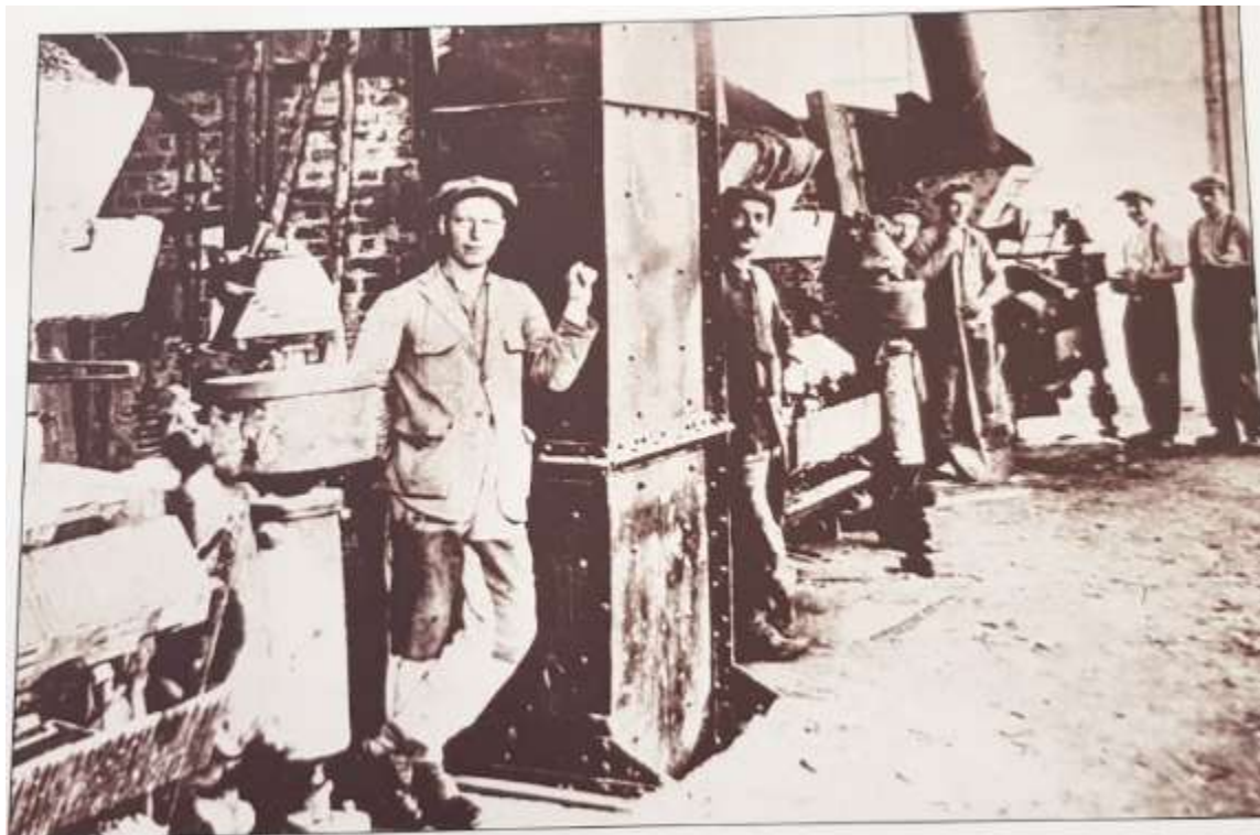
1935 Chaufferie de l'hôpital de Villiers-Saint-Denis, (France).
